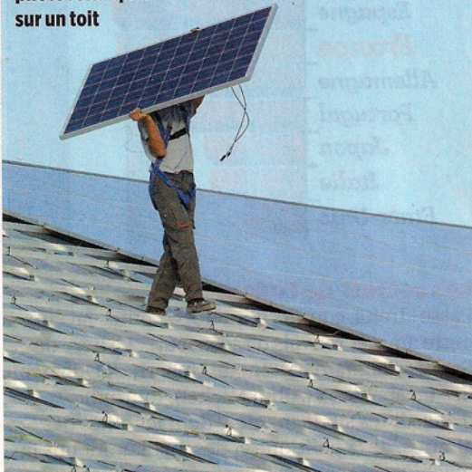
Pose de panneaux photovoltaïques sur un toit
